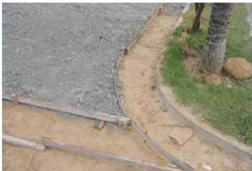
Figura 22 – Fixação das formas de madeiras
