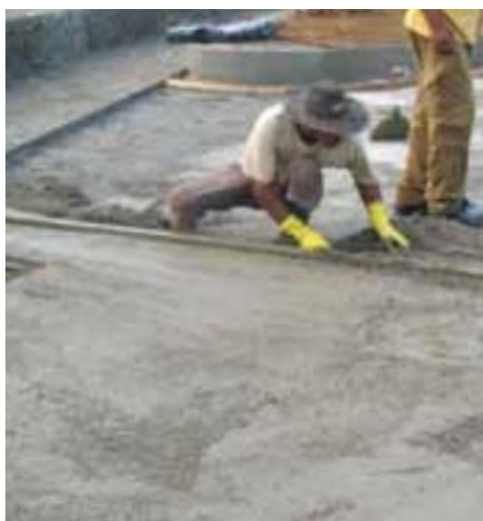
Figura 12 – Sarrafeamento do concreto
