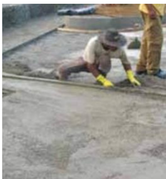
Figura 24 – Sarrafeamento do concreto
