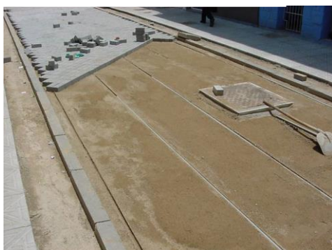
Camada de areia para assentamento.
