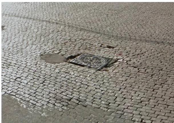
Figura 2 – Desgaste do revestimento em paralelepípedo e ondulações no pavimento.
