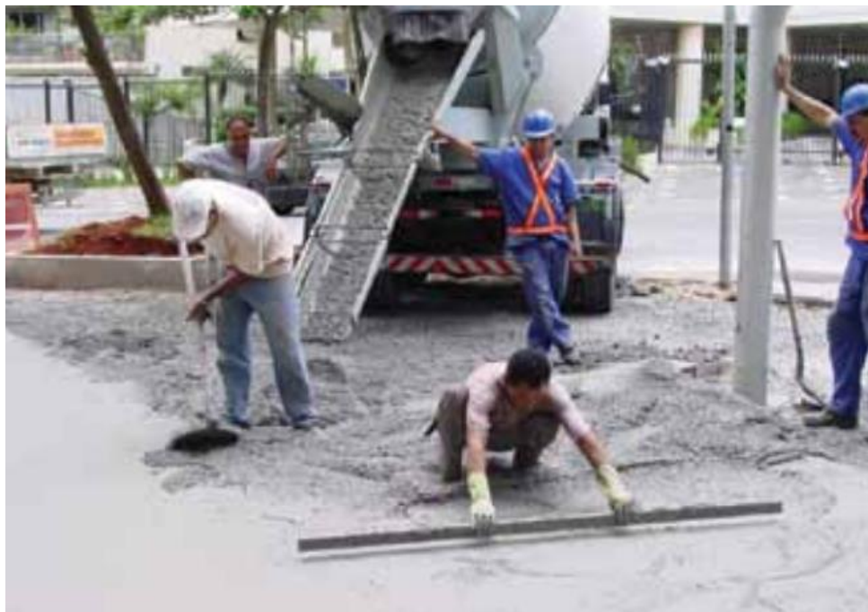
Figura 11 – Recebimento e espalhamento do concreto
