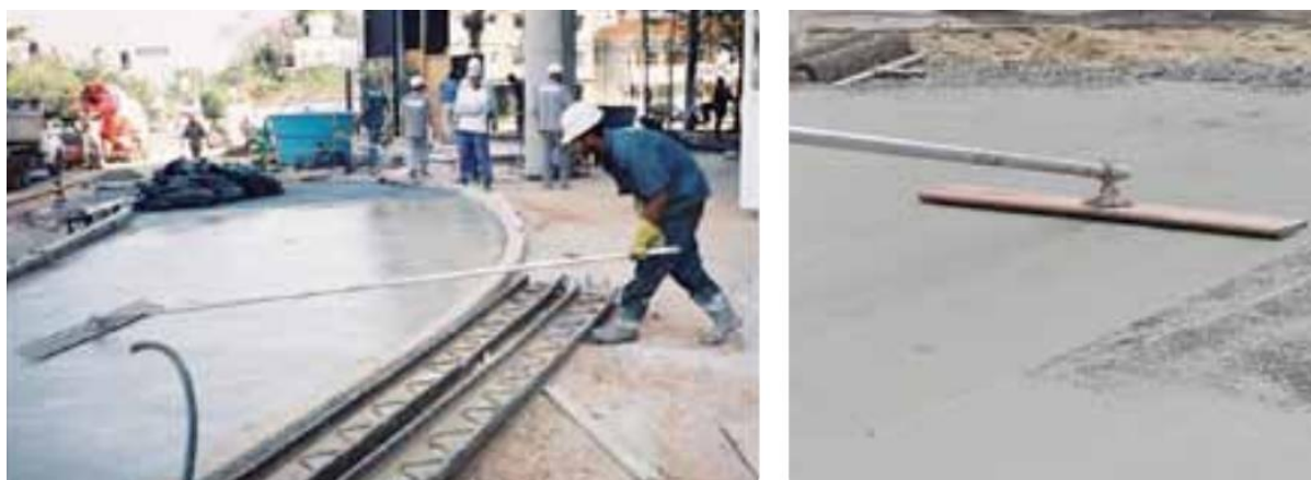
Figura 14 – Desempeno do concreto
