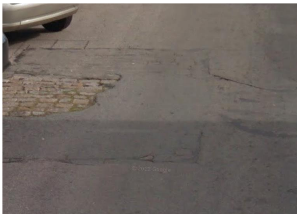
Figura 5: Exposição de pedra regular que compõe o pavimento.
