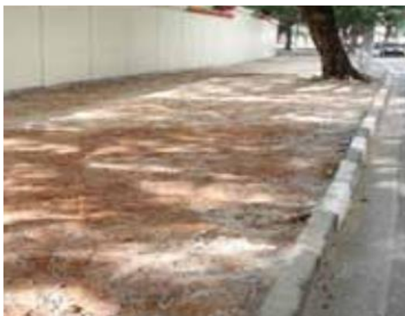
Figura 8 – Nivelamento e compactação do terreno
