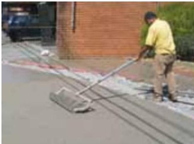
Figura 25 – Rolo rebaixador de concreto
