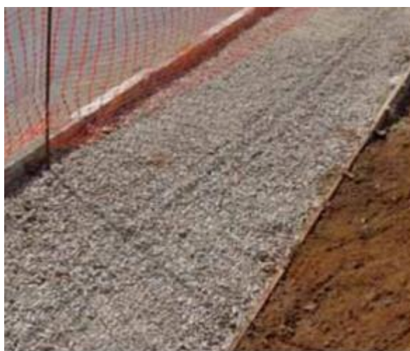
Figura 21 – Espalhamento da Camada de Brita
