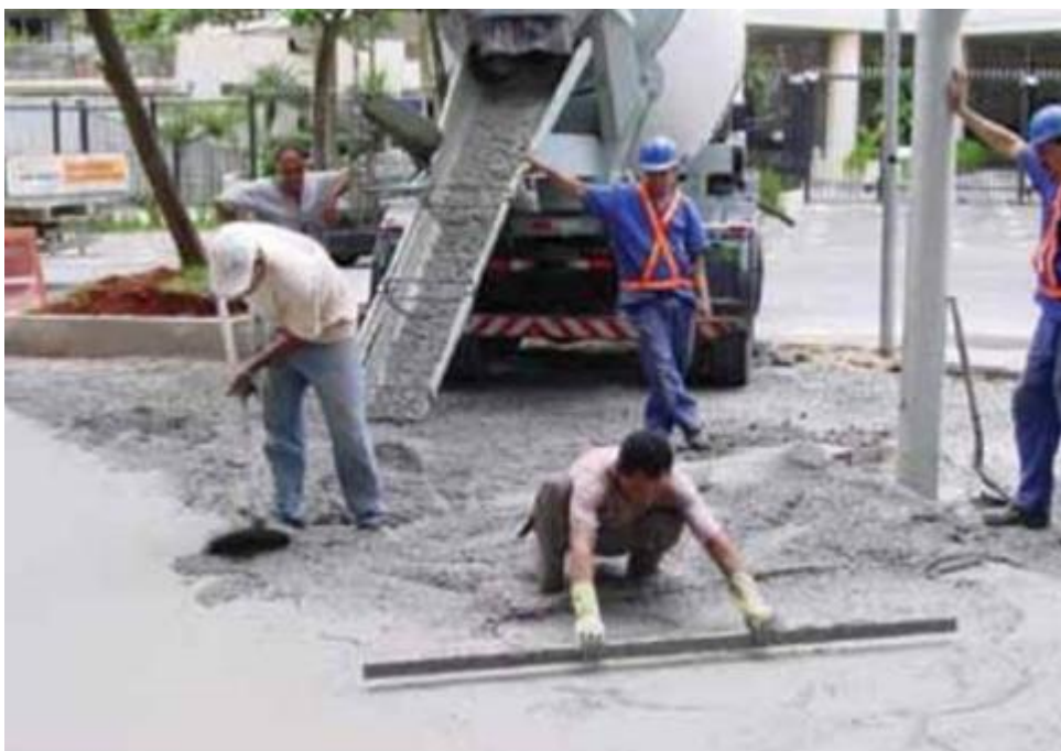
Figura 23 – Recebimento e espalhamento do concreto
