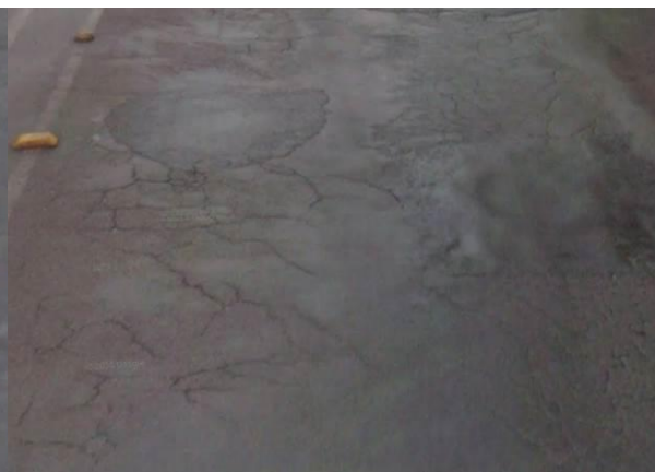
Figura 7 – Remendos existentes e trincas do tipo couro de jacaré.
