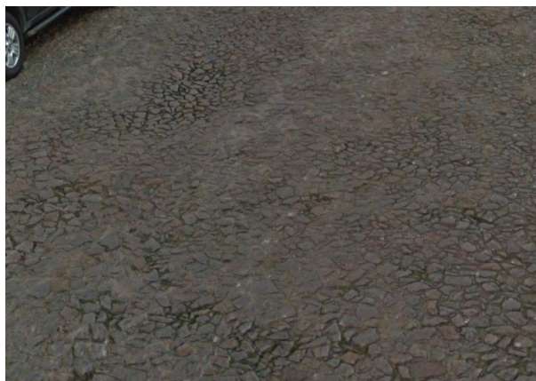
Figura 6: Desgaste da pedra irregular.
