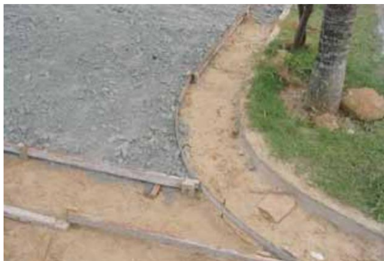
Figura 10 – Fixação das formas de madeiras
