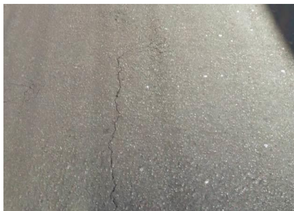
Figura 8 – Trinca longitudinal.
