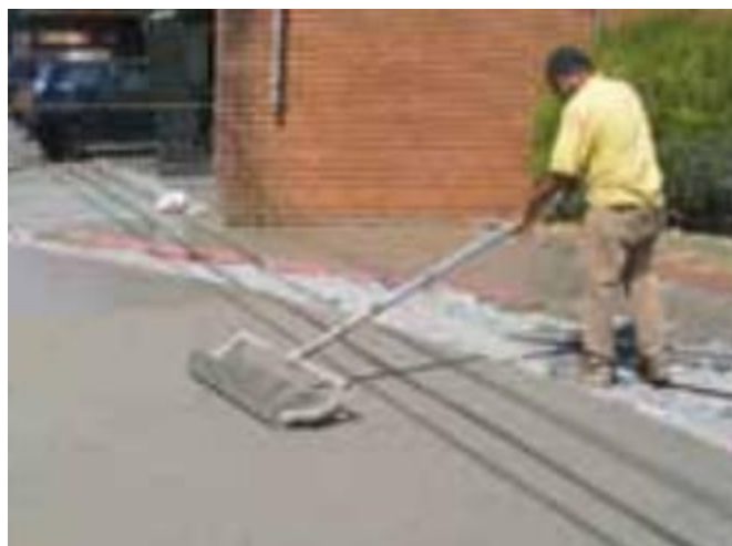
Figura 13 – Rolo rebaixador de concreto
