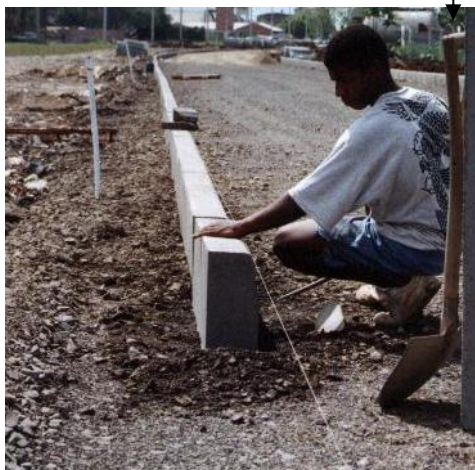
Controle do alinhamento, nivelamento e cota.
