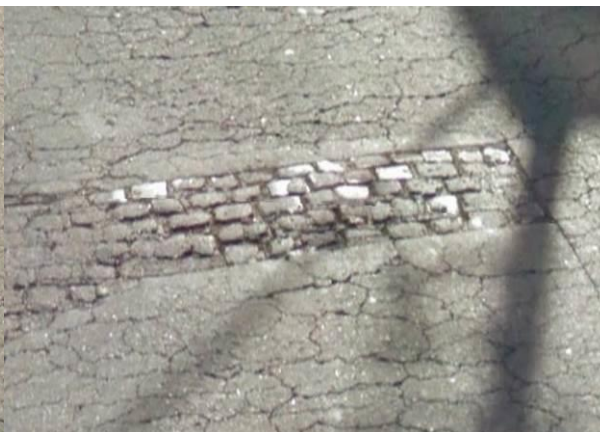
Figura 5 – Exposição de pedra regular que compõe a estrutura do pavimento e trincas do tipo couro de jacaré.
