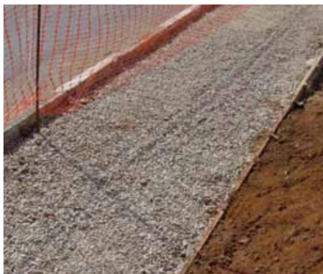
Figura 9 – Espalhamento da Camada de Brita
