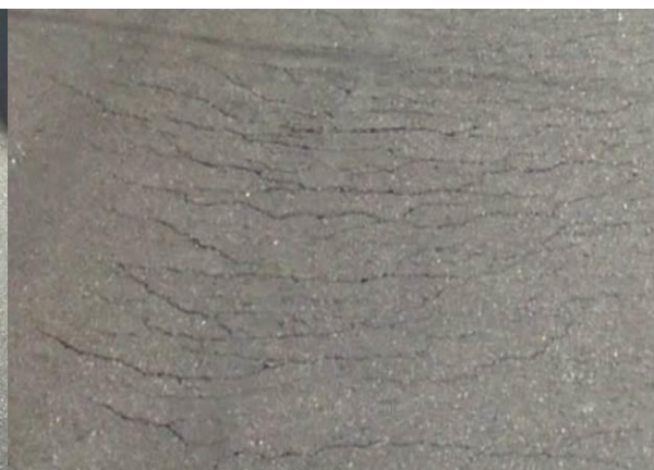
Figura 9 – Trincas transversais.
