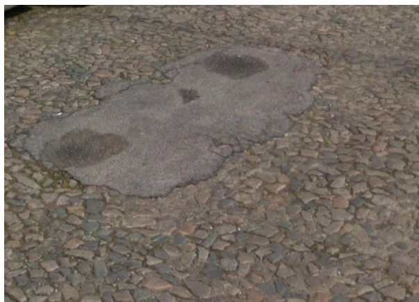
Figura 4: Ondulação causada pelo remendo executado com material asfáltico.
