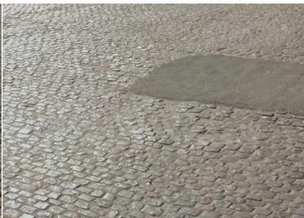
Figura 3 – Desgaste do revestimento em paralelepípedo e remendo realizado com material asfáltico.
