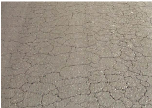
Figura 4 – Trincas do tipo couro de jacaré, existentes ao longo de quase toda a extensão da rua.
