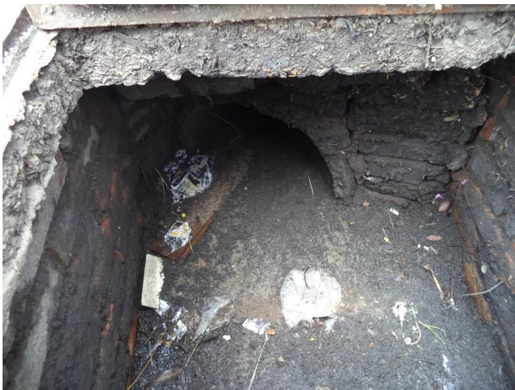
Figura 34 – Caixa existente com presença de detritos.
