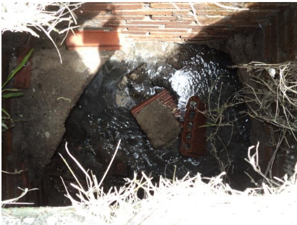
Figura 21 – Caixa existente com presença de detritos obstruindo os locais.
