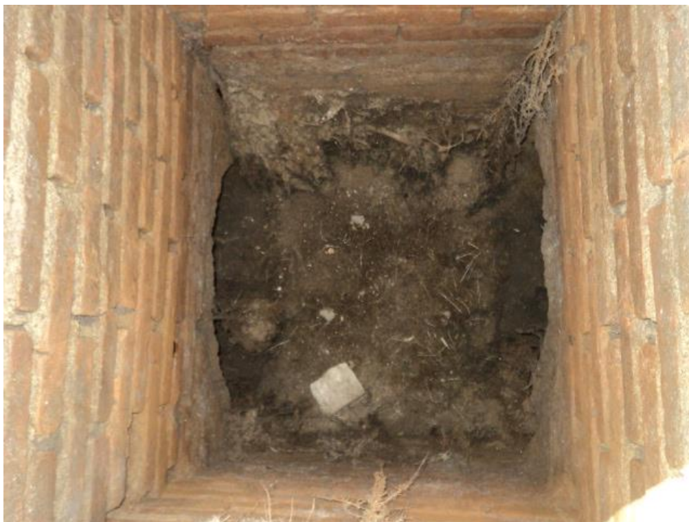
Figura 23 – Caixa existente – serve como depósito de detritos.
