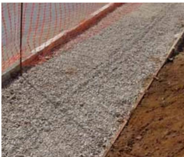
Figura 13: Espalhamento da Camada de Brita
