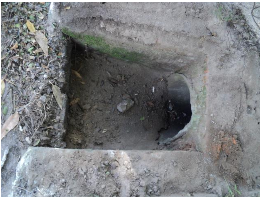
Figura 26 – Caixa existente assoreada.
