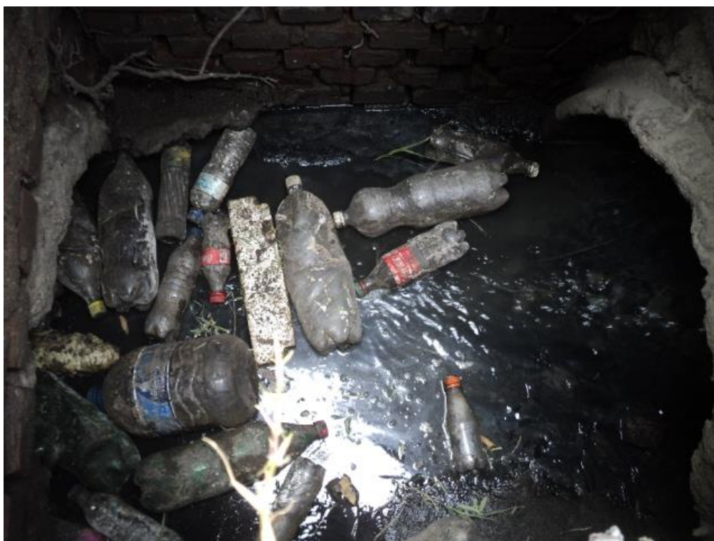
Figura 37 – Caixa existente – serve como depósito de lixo.
