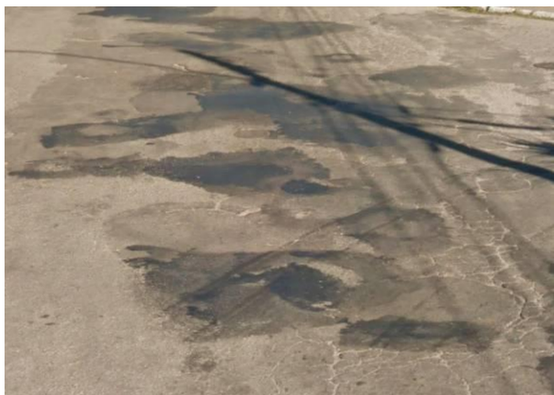
Figura 6 – Sequência de pequenos remendos.
