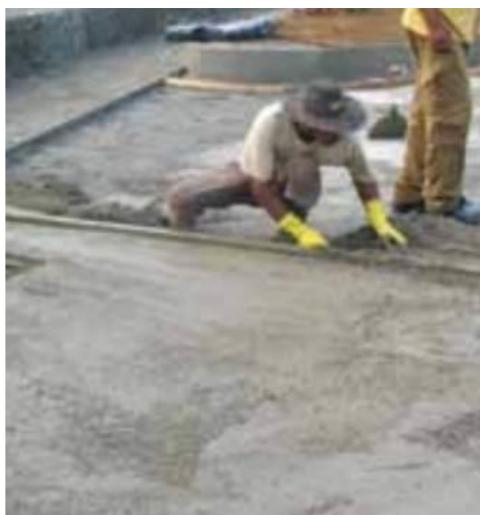
Figura 8 – Sarrafeamento do concreto
