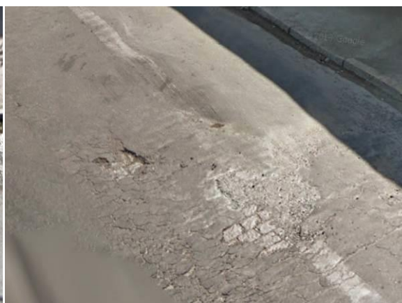
Figura 6 – Ondulação, exposição de pedra regular, trincas e panela.
