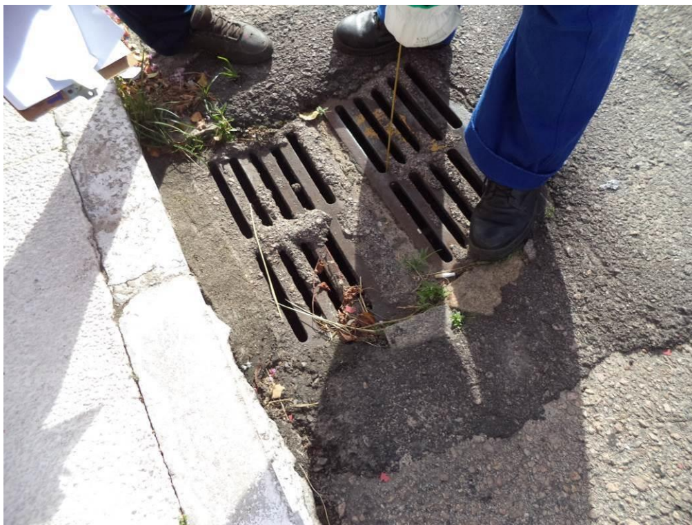
Figura 31 – Boca de lobo com grelha em ferro.
