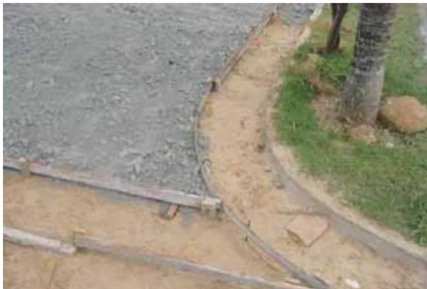
Figura 6 – Fixação das formas de madeiras
