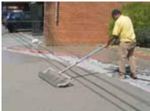
Figura 9 – Rolo rebaixador de concreto
