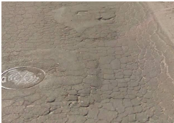
Figura 4 – Trinca do tipo couro de jacaré.
