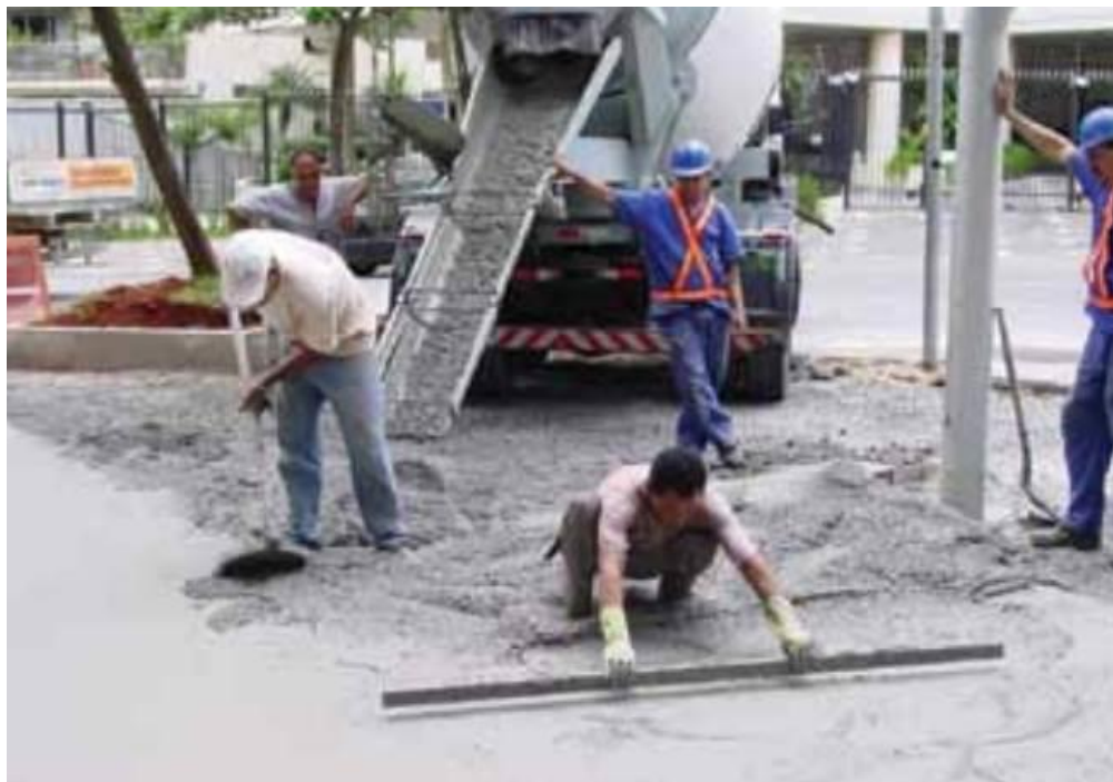
Figura 12 – Recebimento e espalhamento do concreto
