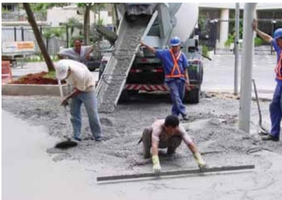
Figura 15: Recebimento e espalhamento do concreto
