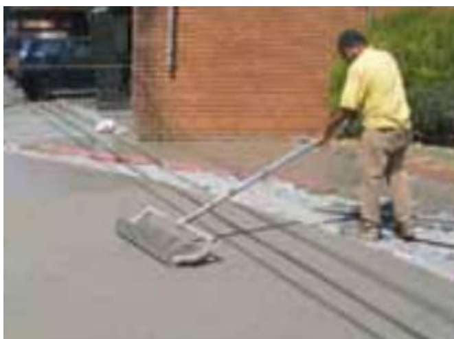
Figura 14 – Rolo rebaixador de concreto
