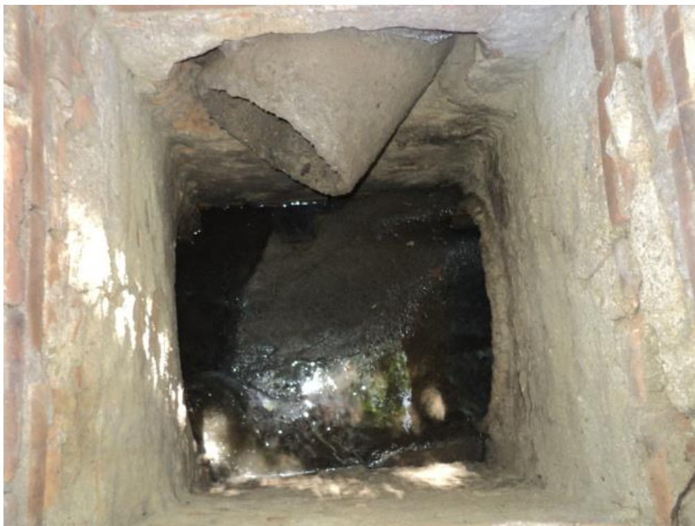
Figura 29 – Caixa existente recebendo contribuição.
