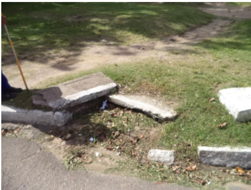
Figura 32 – Caixa existente com tampas quebradas.
