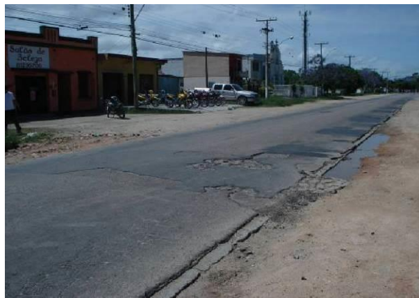
Figura 6 – Remendos, panelas, trincas e exposição de pedra irregular que compõe a estrutura do pavimento.
