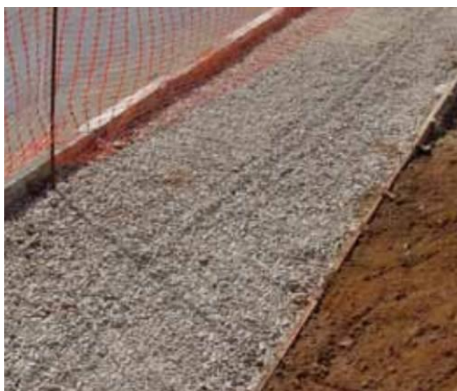
Figura 5 – Espalhamento da Camada de Brita
