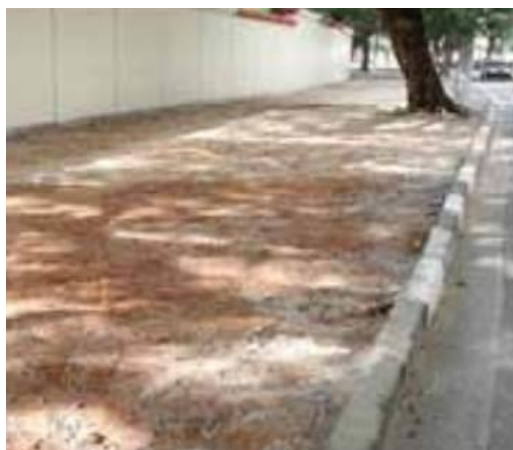
Figura 4 – Nivelamento e compactação do terreno
