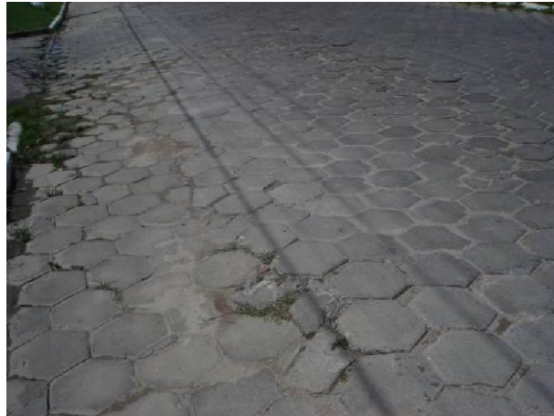
Figura 18 – Pista composta por pavimento de concreto Sextavado
