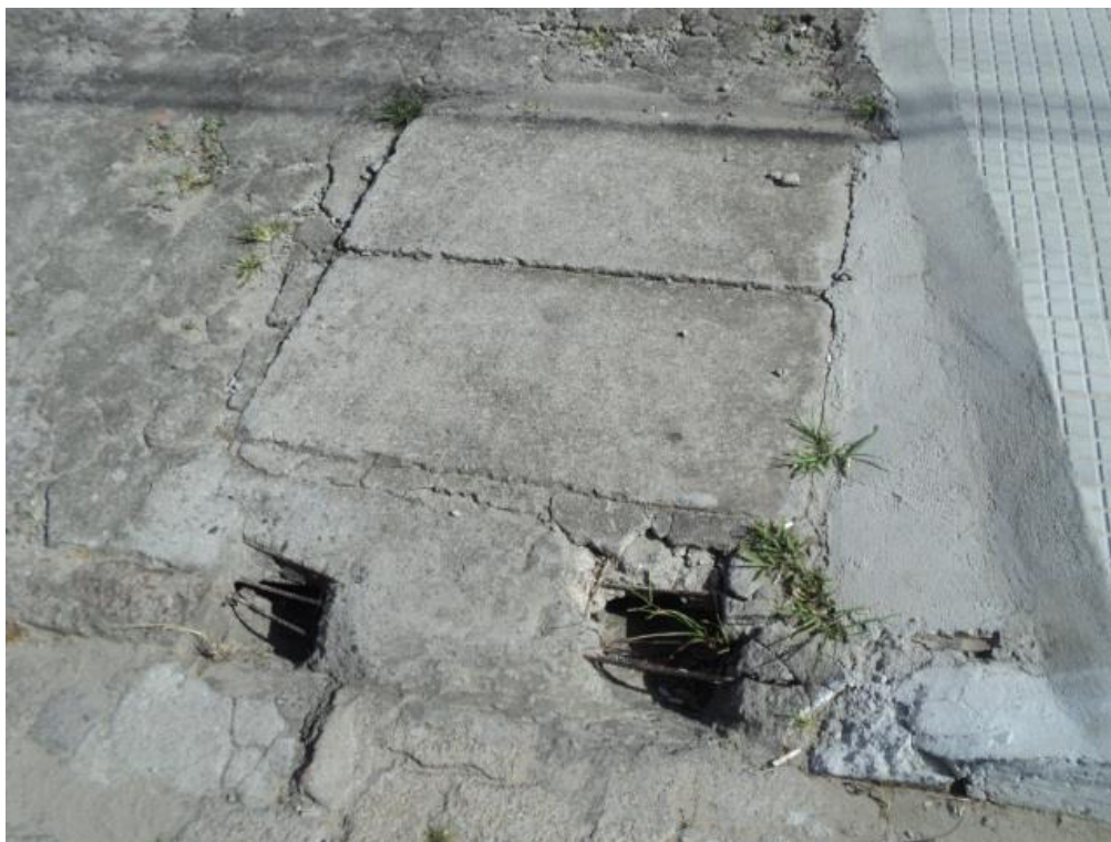
Figura 27 – Boca de lobo – foi concretada após reforma particular, implicando no fechamento da captação.
