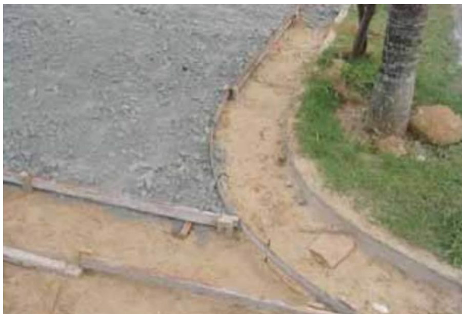
Figura 14: Fixação das formas de madeiras
