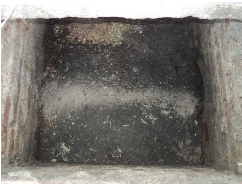
Figura 28 – Caixa existente – bastante assoreado. Detalhe da tubulação enterrada.
