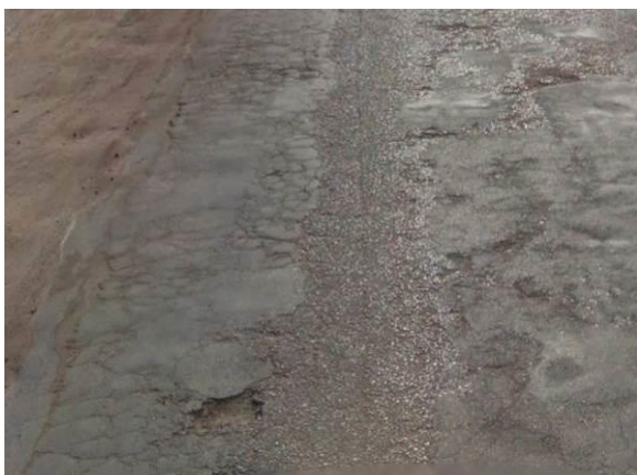
Figura 3: Remendos, trincas do tipo couro de jacaré, desgaste e panela.
