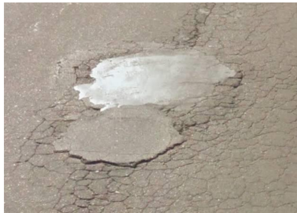
Figura 5 – Remendo sobre trinca do tipo couro de jacaré.
