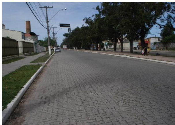
Figura 4 – Pista composta por pavimento intertravado.
