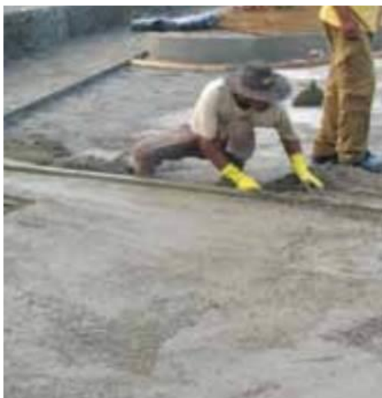
Figura 16: Sarrafeamento do concreto
