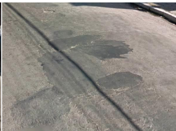
Figura 8 – Remendos e trincas existentes no pavimento.
