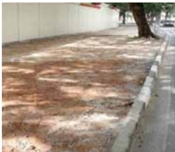
Figura 12: Nivelamento e compactação do terreno
