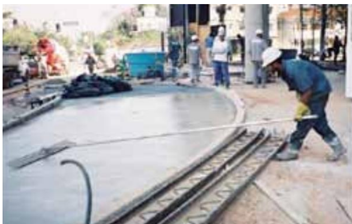
Figura 10 – Desempeno do concreto
