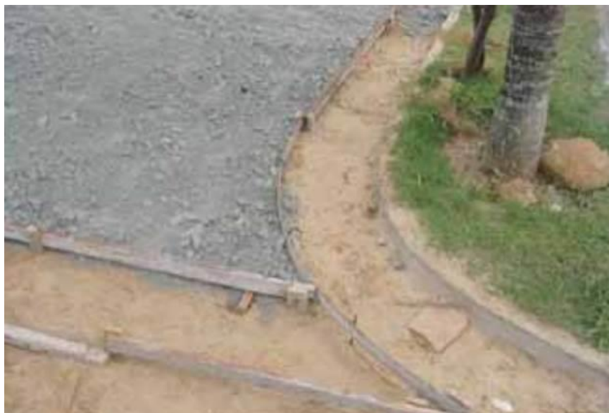
Figura 11 – Fixação das formas de madeiras
