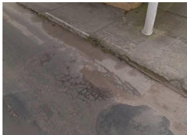
Figura 7 – Afundamento do pavimento, remendo e trincas do tipo couro de jacaré.
