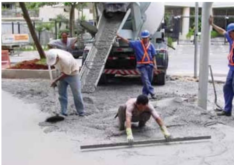
Figura 7 – Recebimento e espalhamento do concreto
