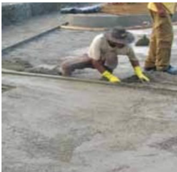
Figura 13 – Sarrafeamento do concreto
