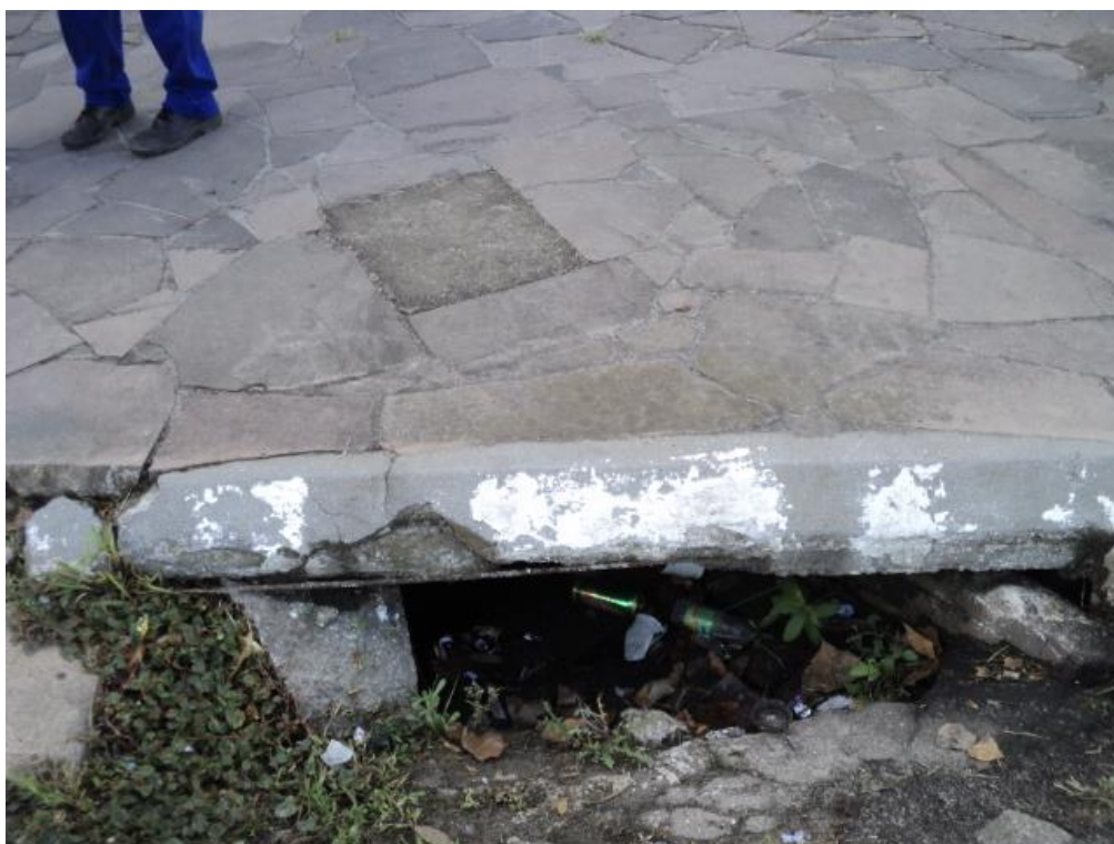
Figura 35 – Boca de lobo existente. Percebe-se nível de detritos praticamente junto à via.
