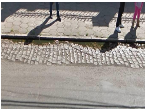
Figura 5 – Exposição de pedra regular que compõe o pavimento.
