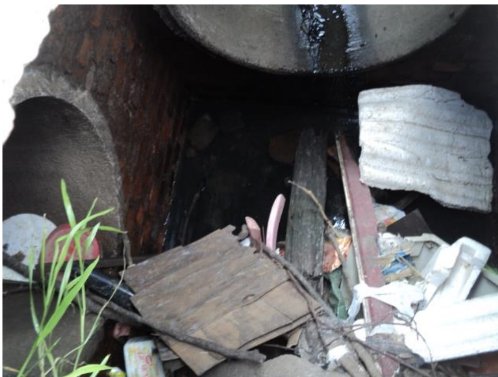
Figura 22 – Caixa existente – nota-se a presença de muitos detritos obstruindo o local e diminuindo a capacidade.
