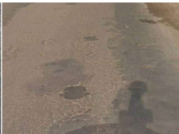
Figura 4: Desgaste, remendos e trincas do tipo couro de jacaré.
