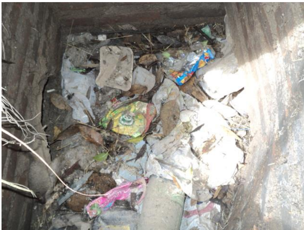
Figura 25 – Caixa existente – serve como depósito de lixo.
