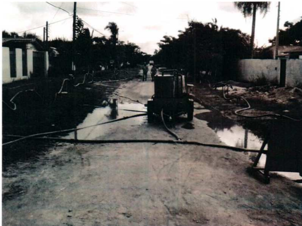
Figura 3.2: Sistema de Rebaixamento "à vácuo"
