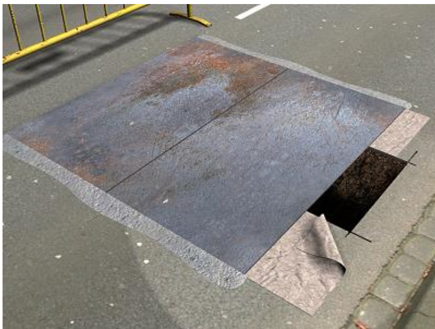
Figura 19 – Exemplo de cobertura de vala com chapa de aço fixada no piso
