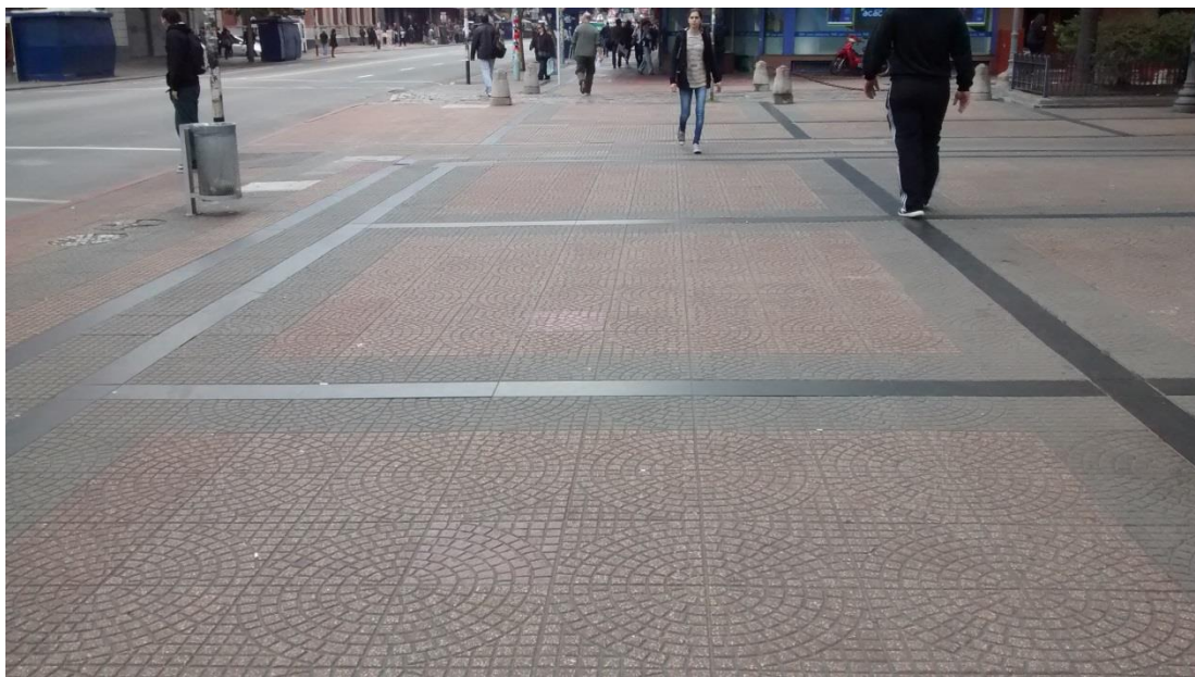
Figura 10 – Composição da paginação com placa de basalto polida
