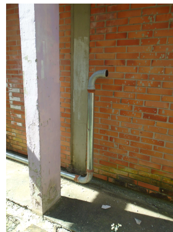
Figura 31: Detalhe para a espera do hidrante
