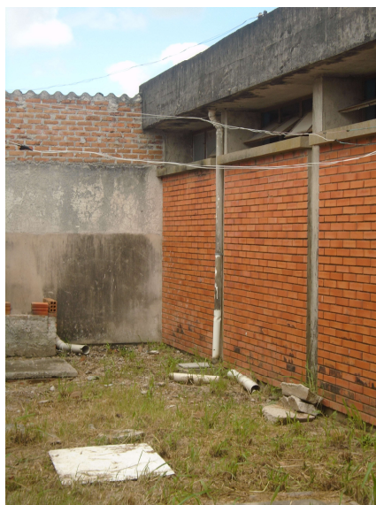
Figura 27: detalhe para o tubo de queda pluvial que deve ser substituído.
