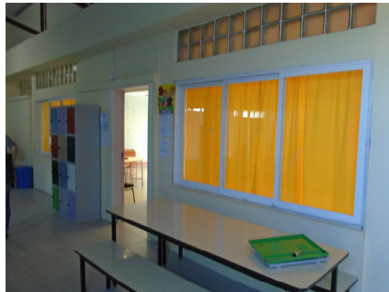
Figura 15: JR2: janela inacabada, colocar acabamento.
