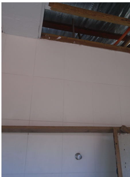
Figura 24: Coluna de água fria instalada. Falta a alimentação por barrilete.
