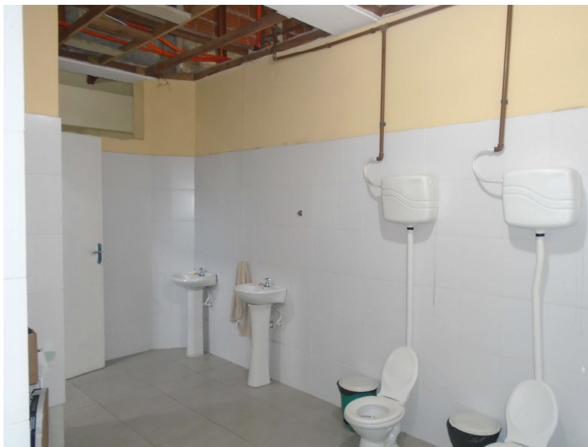
Figura 7; Detalhe da configuração do atual banheiro infantil masculino. Detalhe para as pias com colunas que serão realocadas para o banheiro dos funcionários. Detalhe para a tubulação aparente que deve ser retirada, bem como as caixas de descargas altas.
