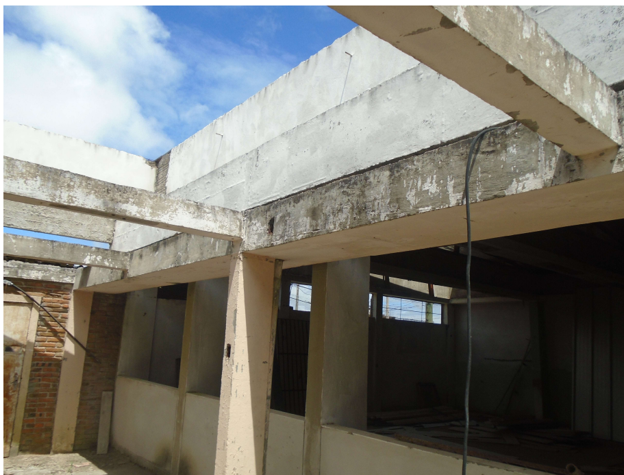
Figura 5: Detalhe da estrutura de concreto armado da circulação. Prevista demolição e retirada.
