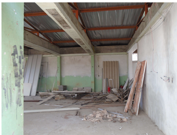
Figura 9: Detalhe para o "dente" das vigas do refeitório. Previsto o fechamento até a parte superior e colocação do forro no topo das vigas.
