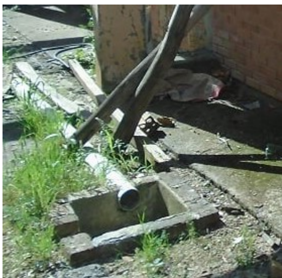
Figura 29: Exemplo de caixa de inspeção que deve ser finalizada.
