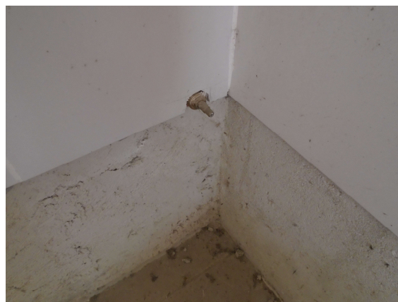
Figura 25: Detalhe para registro instalado sem acabamento.
