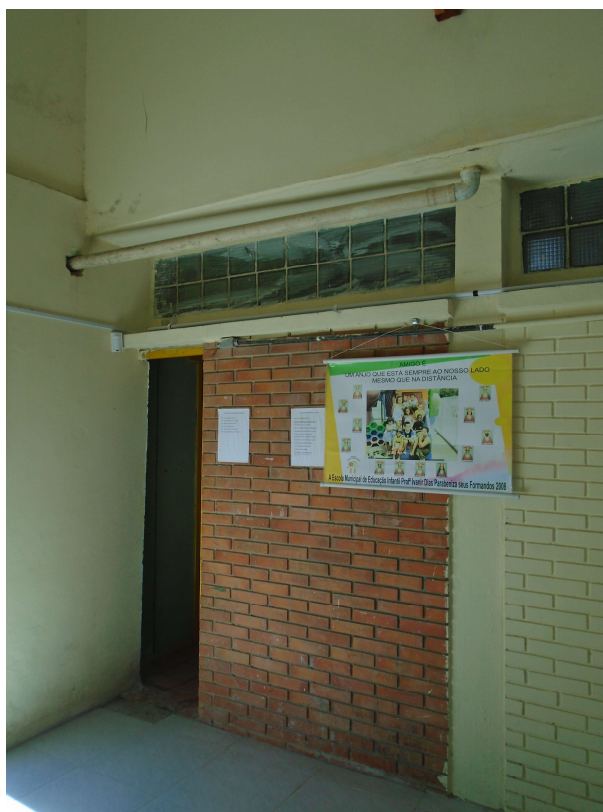
Figura 6: Detalhe para a instalação pluvial provisória que deve ser retirada após a substituição do telhado.
