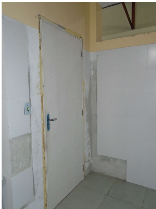
Figura 12: PR3: arrumar batentes, guarnição e marcos. Inclusive pintura.
