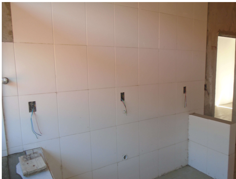
Figura 21: Exemplo de pontos que já possuem fiação, mas falta tomadas e interruptores.
