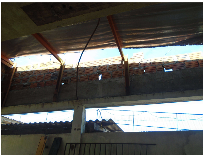
Figura 4: Uma das empenas que deve ser demolida. Posteriormente deve ser refeita com cinta de amarração.
