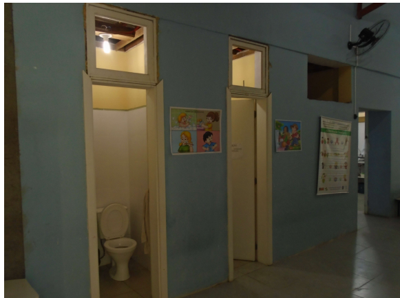
Figura 14: BR1: arrumar guarnição e colocação de vidros.
