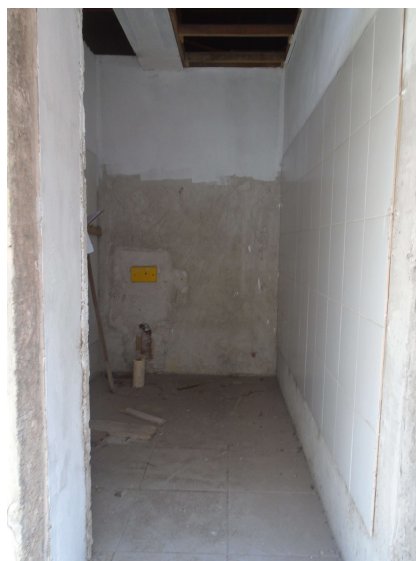
Figura 33: Banheiro PCD. Detalhe para a caixa de descarga embutida já instalada.
