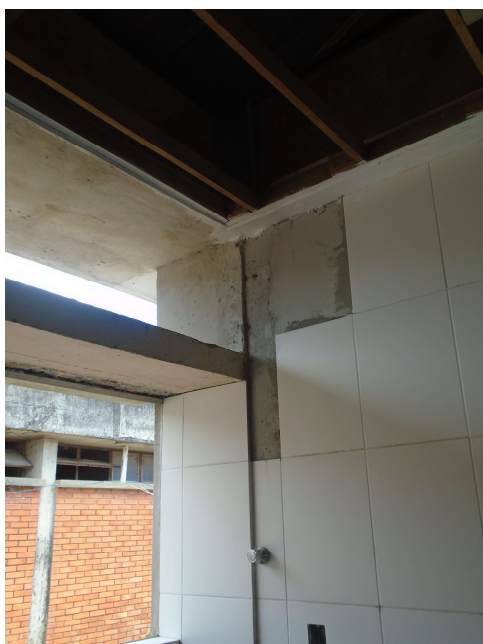
Figura 26: Detalhe para registro instalado completo.
