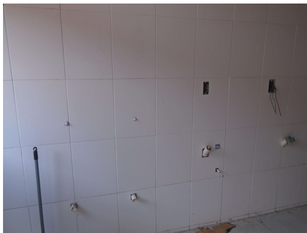
Figura 23: Parte já iniciada com instalações de água fria.
