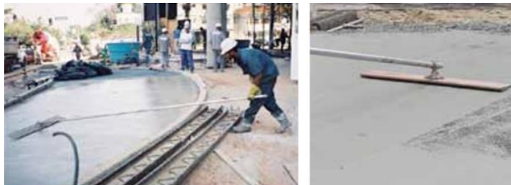
Figura 11 – Desempeno do concreto.
