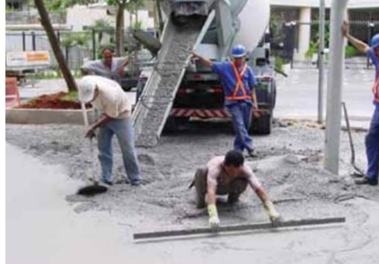
Figura 10 – Recebimento e espalhamento do concreto.
