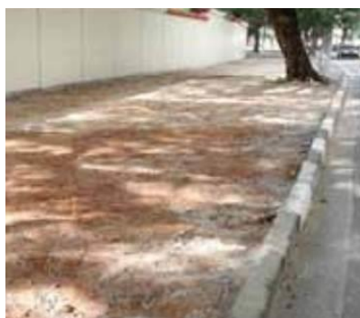
Figura 8 – Nivelamento e compactação do terreno
