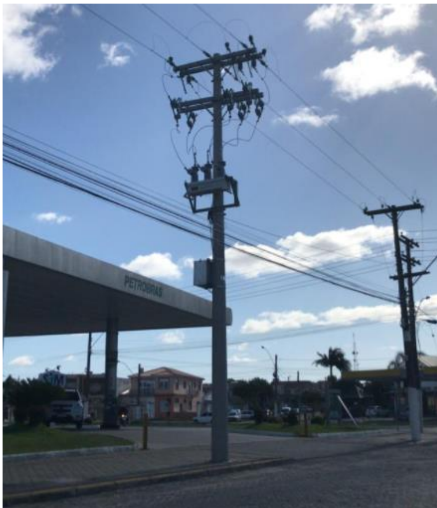
Poste 2 - Entrada Rua Izabel Maria Pereira Satte Alam
