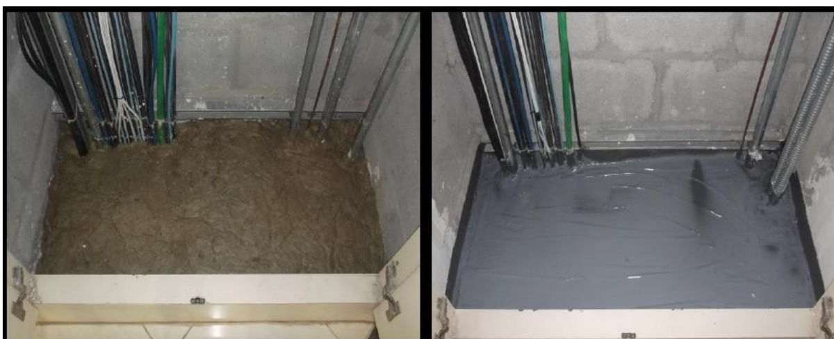
Figura 5 - Compartimentação do Shaft
