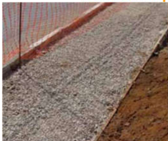
Figura 10 – Espalhamento da camada de Brita
