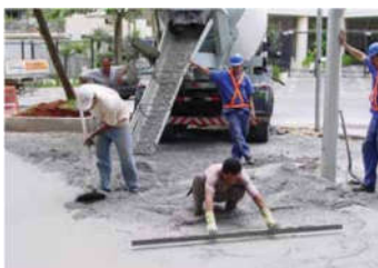
Figura 11 – Recebimento e espalhamento do concreto.
