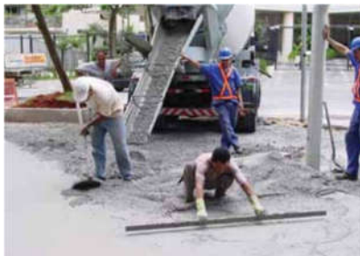
Figura 13 – Recebimento e espalhamento do concreto.
