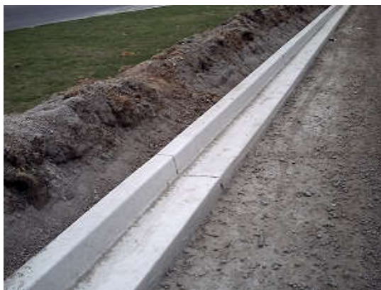
Figura 5 – Detalhe Guia e Sarjeta Conjugados Extrusados.
