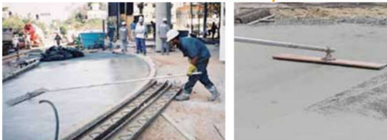
Figura 14 – Desempeno do concreto.
