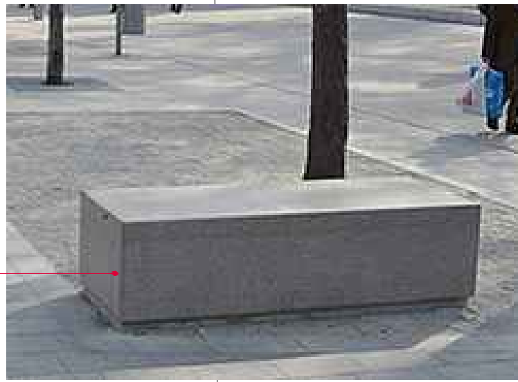
Banco em alvenaria com capeamento em concreto em 2 módulos - módulo 01 para adultos e módulo 02 para crianças, mais baixo.
