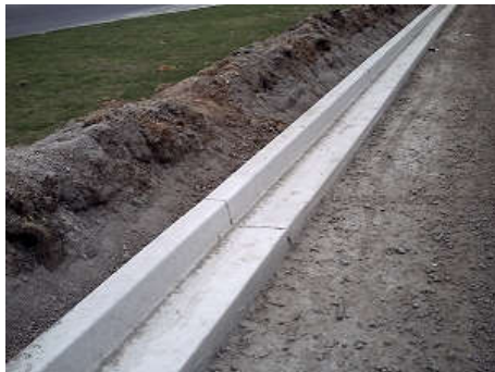
Figura 4 – Detalhe Guia e Sarjeta Conjugados Extrusados.
