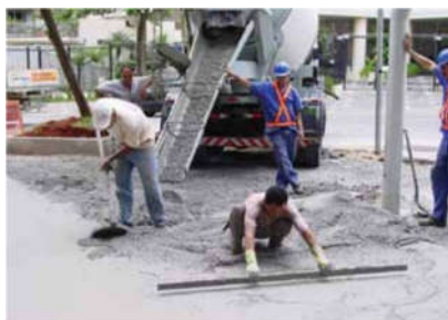
Figura 10 – Recebimento e espalhamento do concreto.
