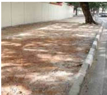
Figura 8 – Nivelamento e compactação do terreno
