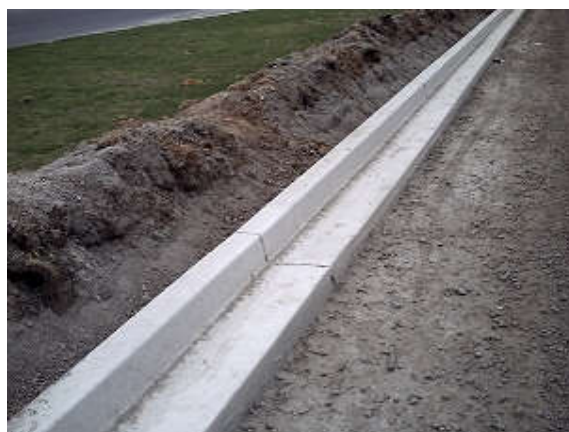
Figura 3 – Detalhe Guia e Sarjeta Conjugados Extrusados.
