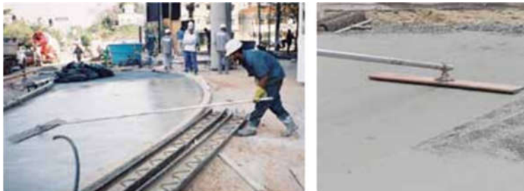
Figura 13 – Desempeno do concreto.
