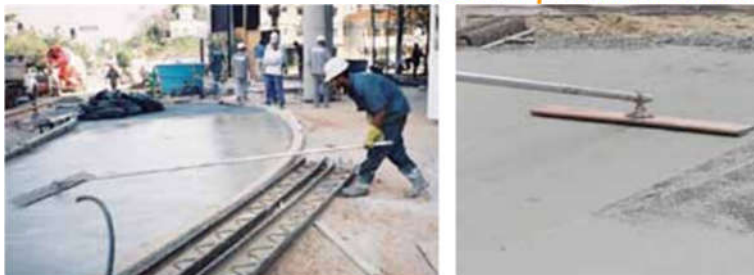
Figura 11 – Desempeno do concreto.
