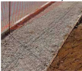
Figura 11 – Espalhamento da camada de Brita
