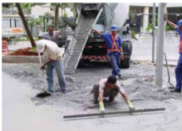
Figura 12 – Recebimento e espalhamento do concreto.
