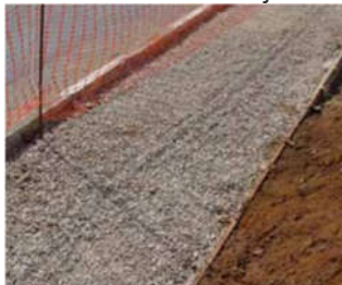
Figura 9 – Espalhamento da camada de Brita
