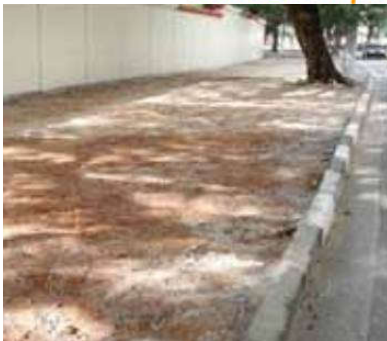
Figura 10 – Nivelamento e compactação do terreno
