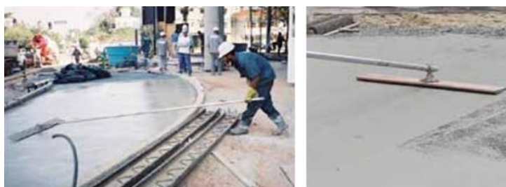
Figura 6 – Desempeno do concreto.
