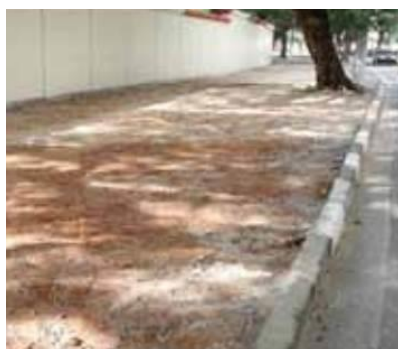
Figura 4 – Nivelamento e compactação do terreno
