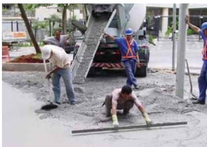
Figura 5 – Recebimento e espalhamento do concreto.
