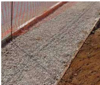
Figura 5 – Espalhamento da camada de Brita
