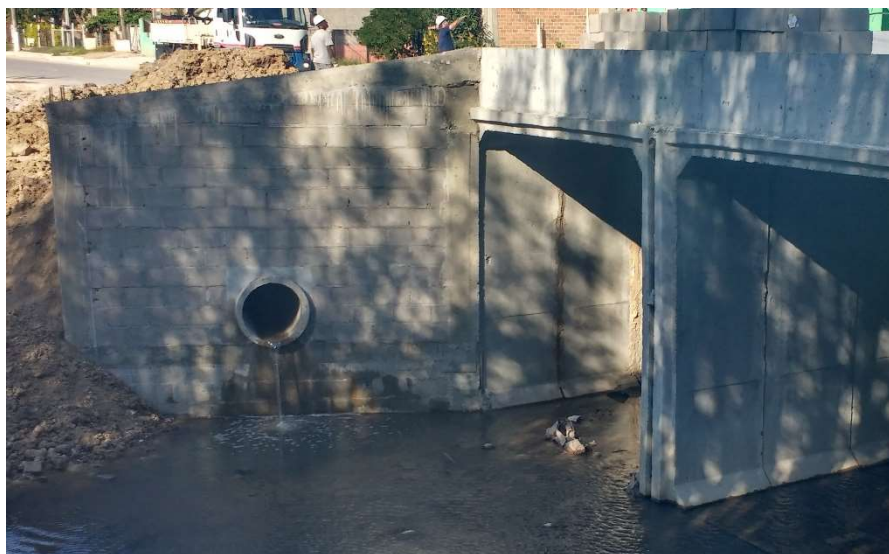
Figura 15 – Exemplo construtivo de Alvenaria de embasamento - Alas
