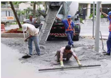
Figura 6 – Recebimento e espalhamento do concreto.
