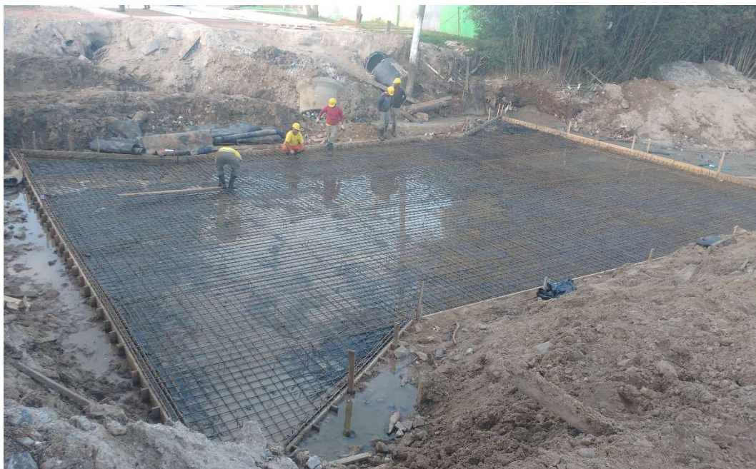
Figura 14 – Método construtivo de Radier
