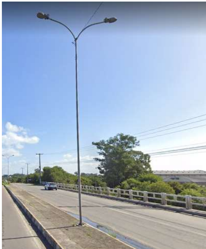
Foto 1 – Local da instalação
