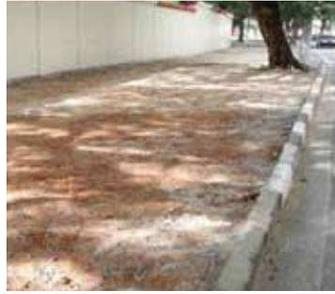
Figura 11 – Nivelamento e compactação do terreno
