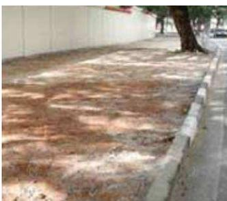
Figura 11 – Nivelamento e compactação do terreno
