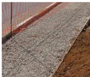
Figura 12 – Espalhamento da camada de Brita
