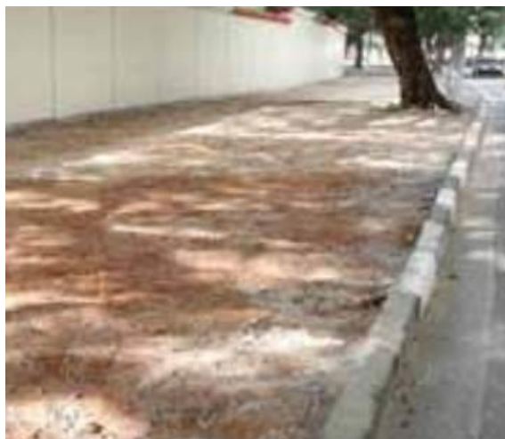
Figura 4 - Nivelamento e compactação do terreno
