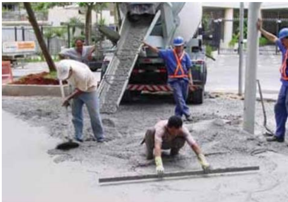
Figura 7 - Recebimento e espalhamento do concreto
