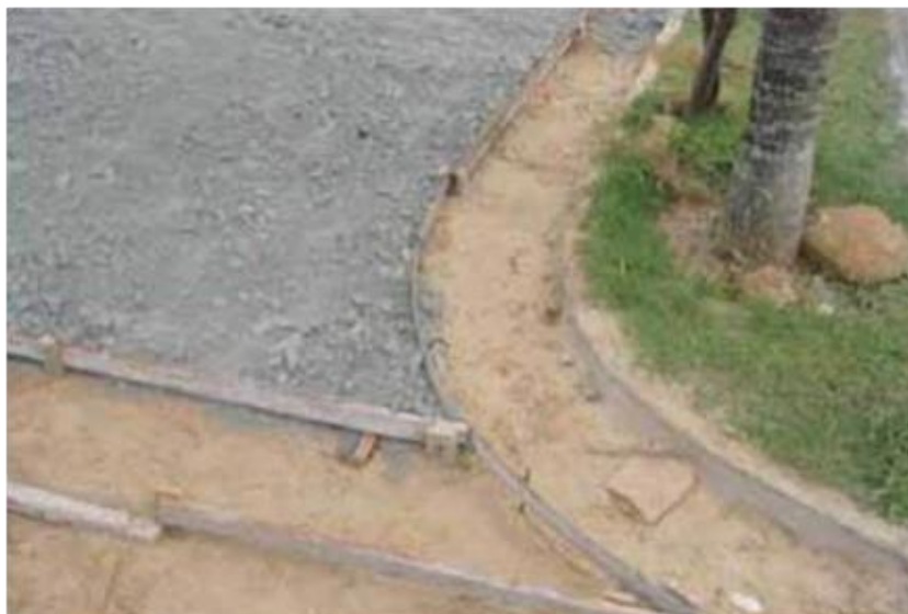
Figura 6 - Fixação das formas de madeiras
