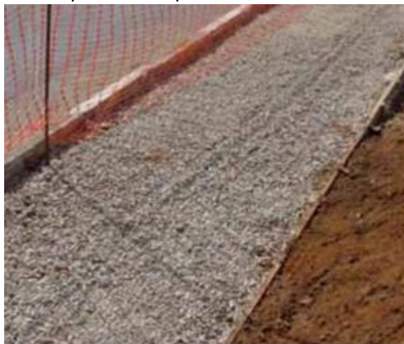
Figura 5 - Espalhamento da Camada de Brita
