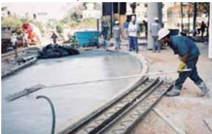
Figura 10 - Desempeno do concreto
