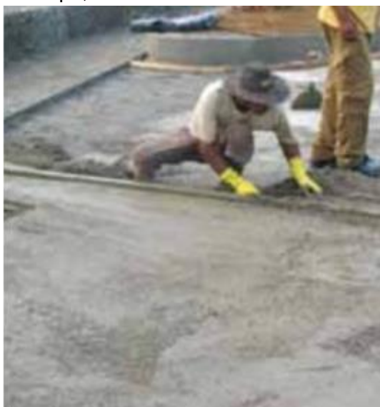
Figura 8 - Sarrafeamento do concreto
