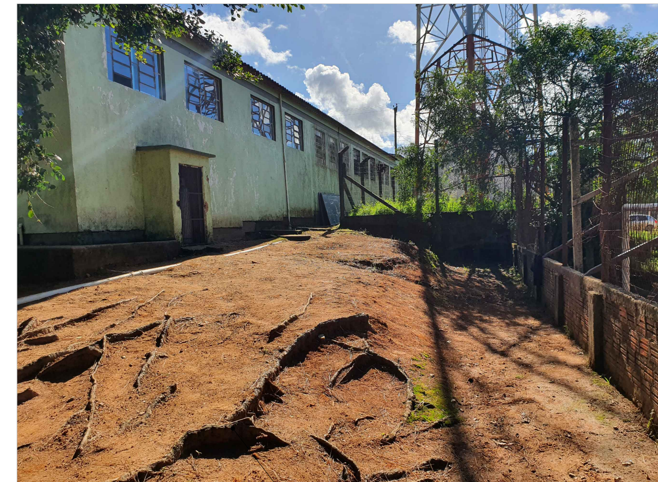
A- RAÍZES SERÃO DESTOCADAS (*C/PERMISSÃO TÉCNICA DA SGA)
