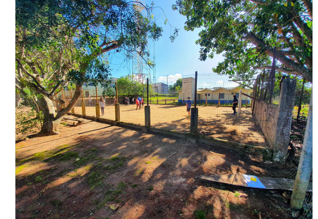
A- TELA SERÁ RETIRADA; B- PERFIL METÁLICO SERÁ RETIRADO; C- BALDRAME SERÁ DEMOLIDO.
