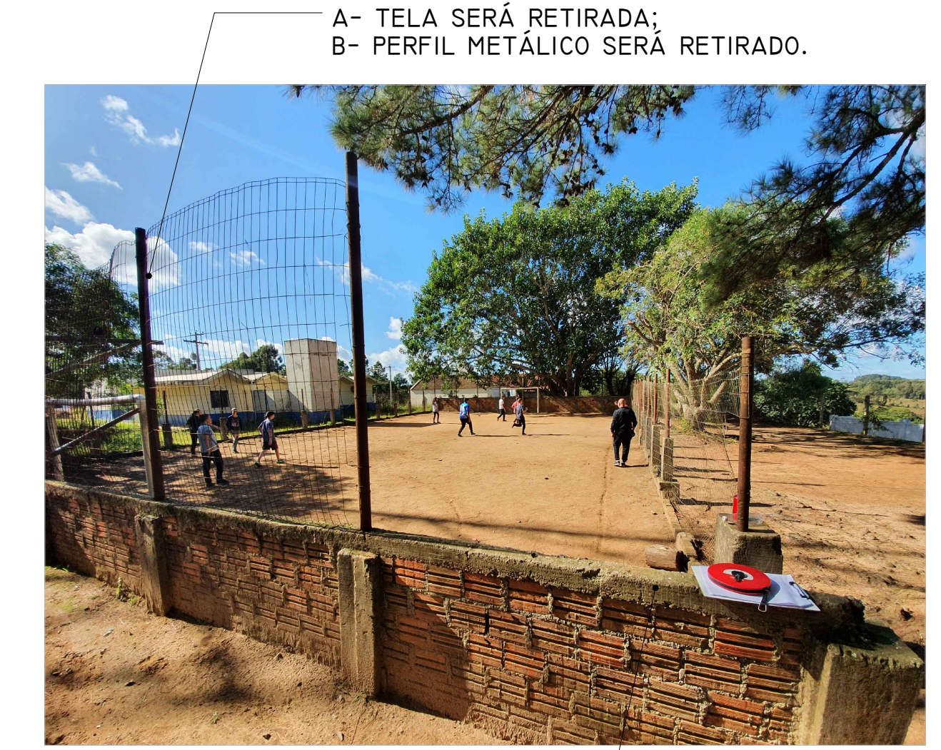
A- TELA SERÁ RETIRADA; B- PERFIL METÁLICO SERÁ RETIRADO. C- MURETA SERÁ DESMANCHADA; D- ESTRUTURA EM CONCRETO SERÁ DEMOLIDA.
