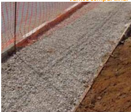
Figura 7 – Espalhamento da camada de Brita
