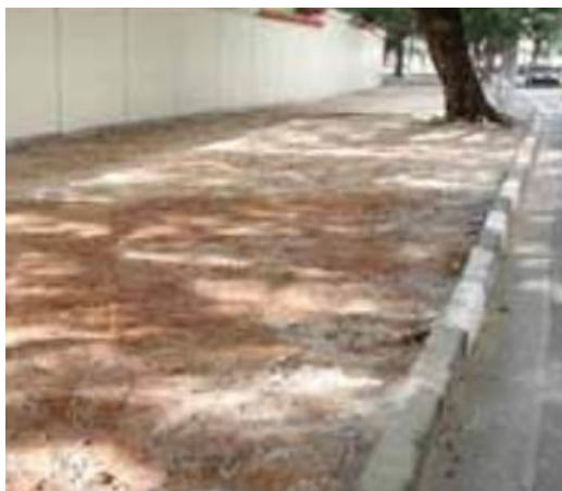
Figura 6 – Nivelamento e compactação do terreno
