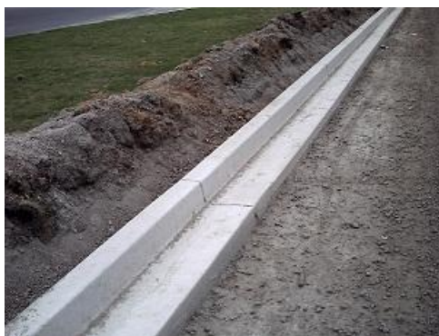
Figura 4 - Detalhe Guia e Sarjeta Conjugados Extrusados.
