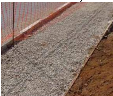
Figura 11 - Espalhamento da camada de Brita
