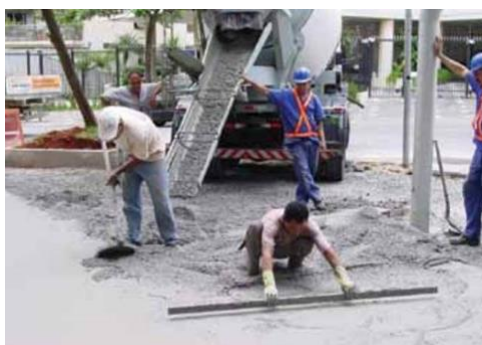
Figura 8 – Recebimento e espalhamento do concreto.
