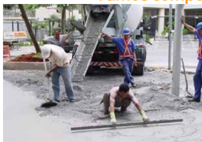
Figura 12 - Recebimento e espalhamento do concreto.
