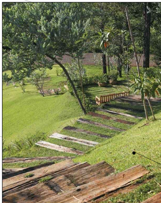
Toras de madeira encravadas no talude para serem utilizadas como caminho / degraus de acesso ao parquinho
