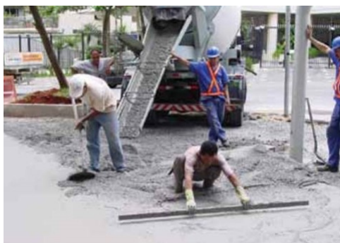
Figura 8 – Recebimento e espalhamento do concreto.
