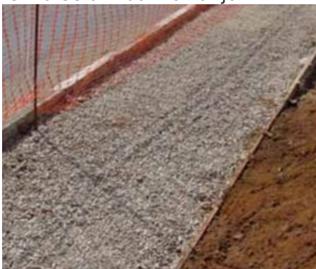
Figura 7 – Espalhamento da camada de Brita
