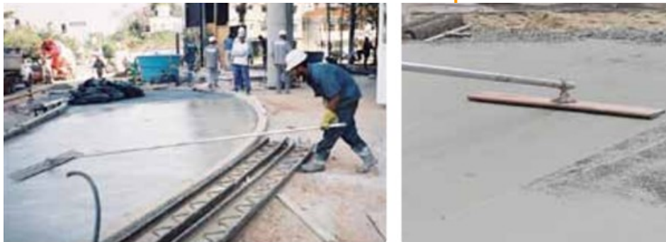
Figura 9 – Desempeno do concreto.
