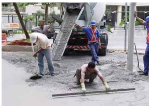
Figura 8 – Recebimento e espalhamento do concreto.
