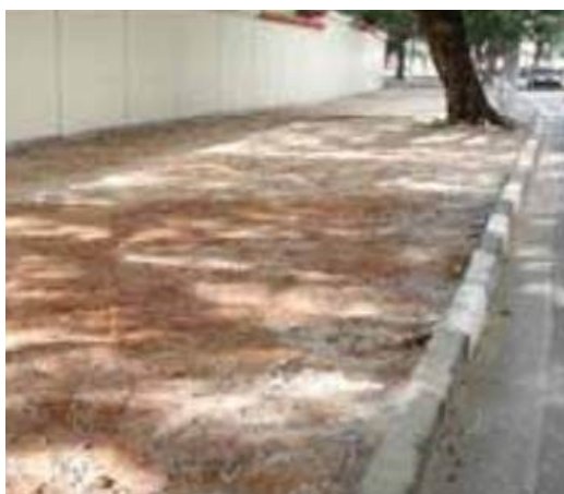
Figura 6 – Nivelamento e compactação do terreno
