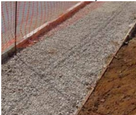
Figura 7 – Espalhamento da camada de Brita
