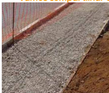
Figura 11 – Espalhamento da camada de Brita
