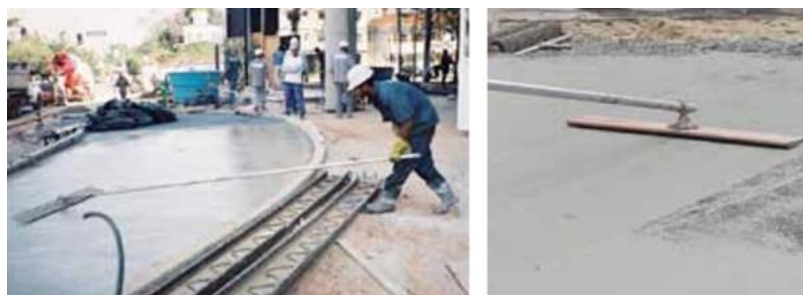
Figura 13 – Desempeno do concreto.
