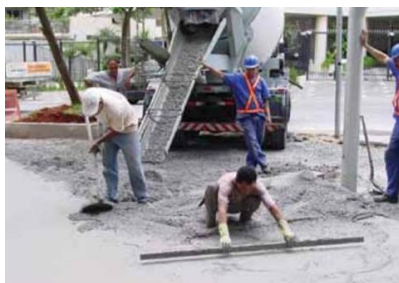
Figura 12 – Recebimento e espalhamento do concreto.
