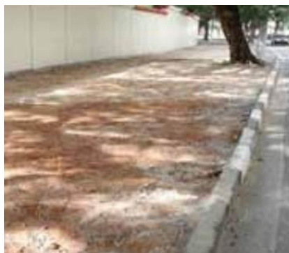
Figura 10 – Nivelamento e compactação do terreno
