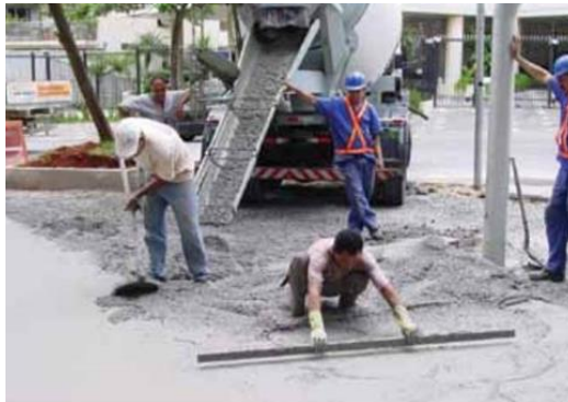
Figura 5 – Recebimento e espalhamento do concreto.
