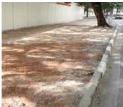
Figura 4 – Nivelamento e compactação do terreno
