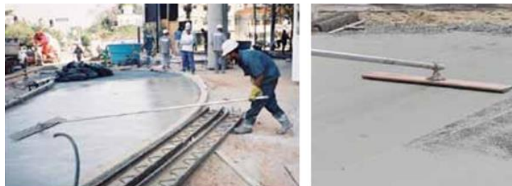
Figura 6 – Desempeno do concreto.
