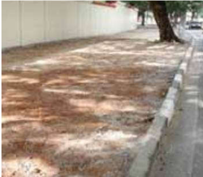
Figura 15– Nivelamento e compactação do terreno
