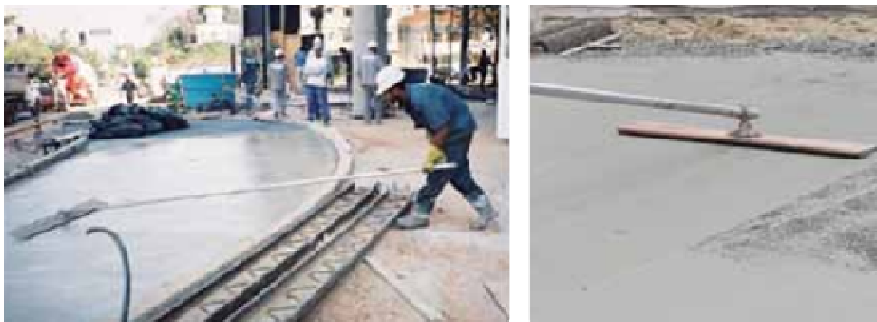
Figura 19 – Desempeno do concreto.
