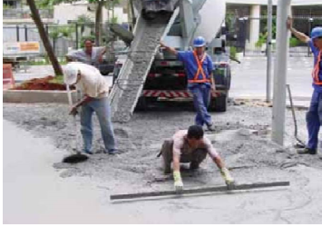
Figura 17– Recebimento e espalhamento do concreto.
