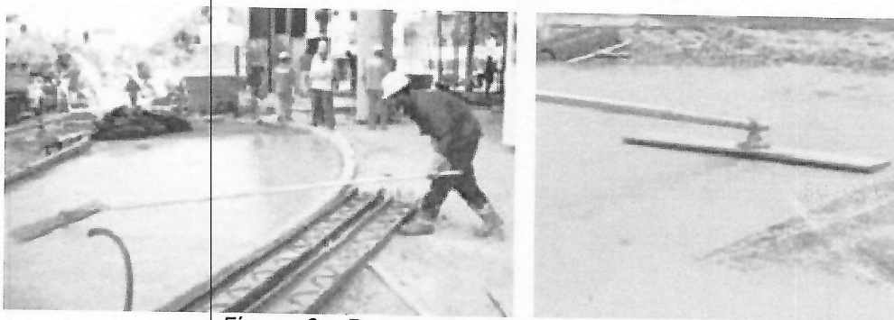
Figura 9 – Desempeno do concreto.
