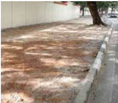
Figura 15– Nivelamento e compactação do terreno
