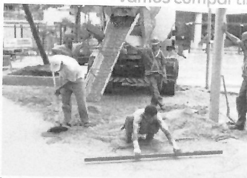
Figura 8 – Recebimento e espalhamento do concreto.
