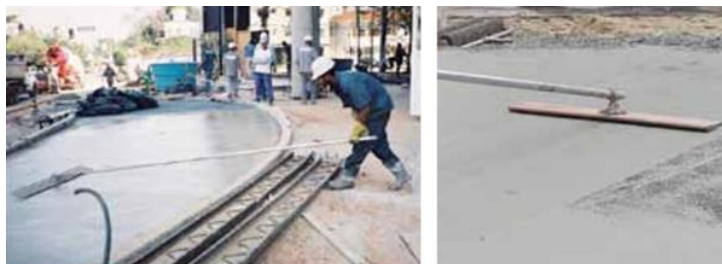
Figura 6 – Desempeno do concreto.
