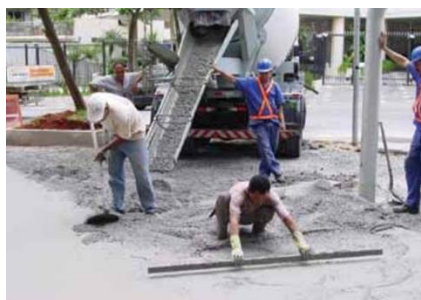
Figura 5 – Recebimento e espalhamento do concreto.
