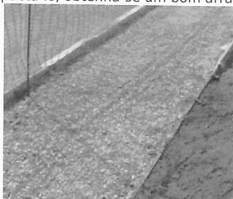
Figura 7 – Espalhamento da camada de Brita
