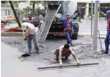
Figura 17– Recebimento e espalhamento do concreto.
