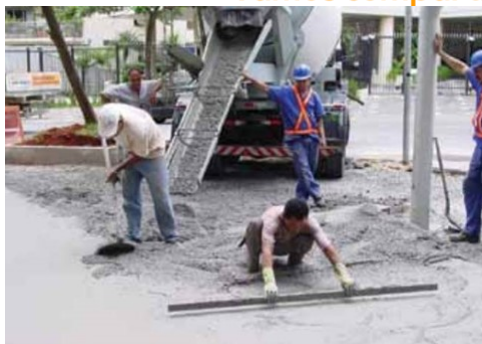
Figura 8 – Recebimento e espalhamento do concreto.
