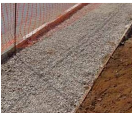
Figura 7 – Espalhamento da camada de brita
