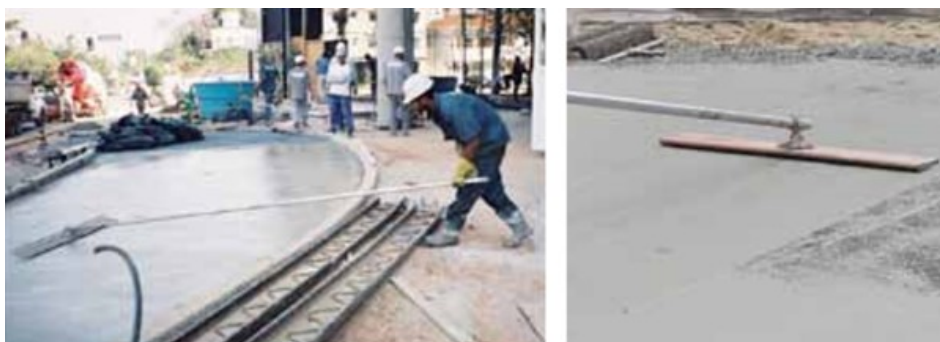
Figura 9 – Desempeno do concreto.
