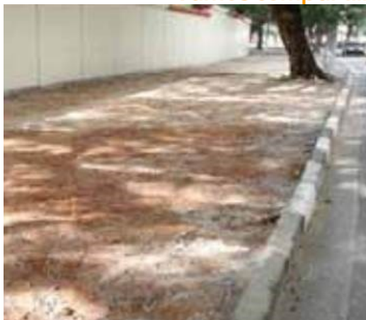
Figura 6 – Nivelamento e compactação do terreno
