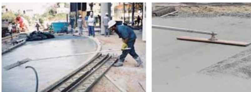
Figura 13 – Desempeno do concreto.
