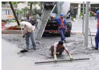
Figura 12 – Recebimento e espalhamento do concreto.
