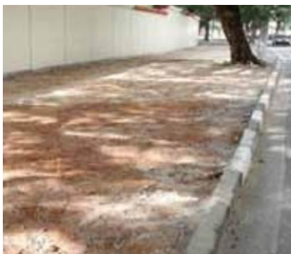
Figura 10 – Nivelamento e compactação do terreno
