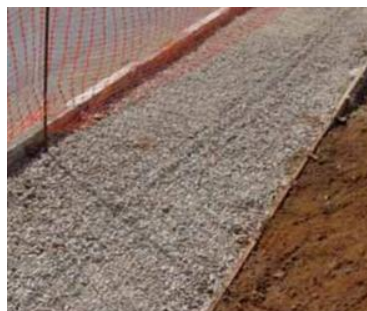
Figura 11 – Espalhamento da camada de Brita
