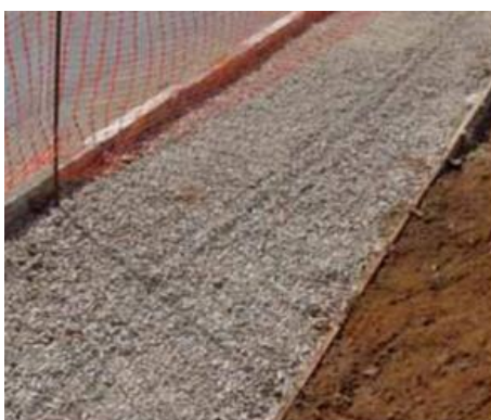
Figura 5 – Espalhamento da camada de brita
