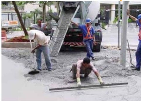
Figura 6 – Recebimento e espalhamento do concreto.
