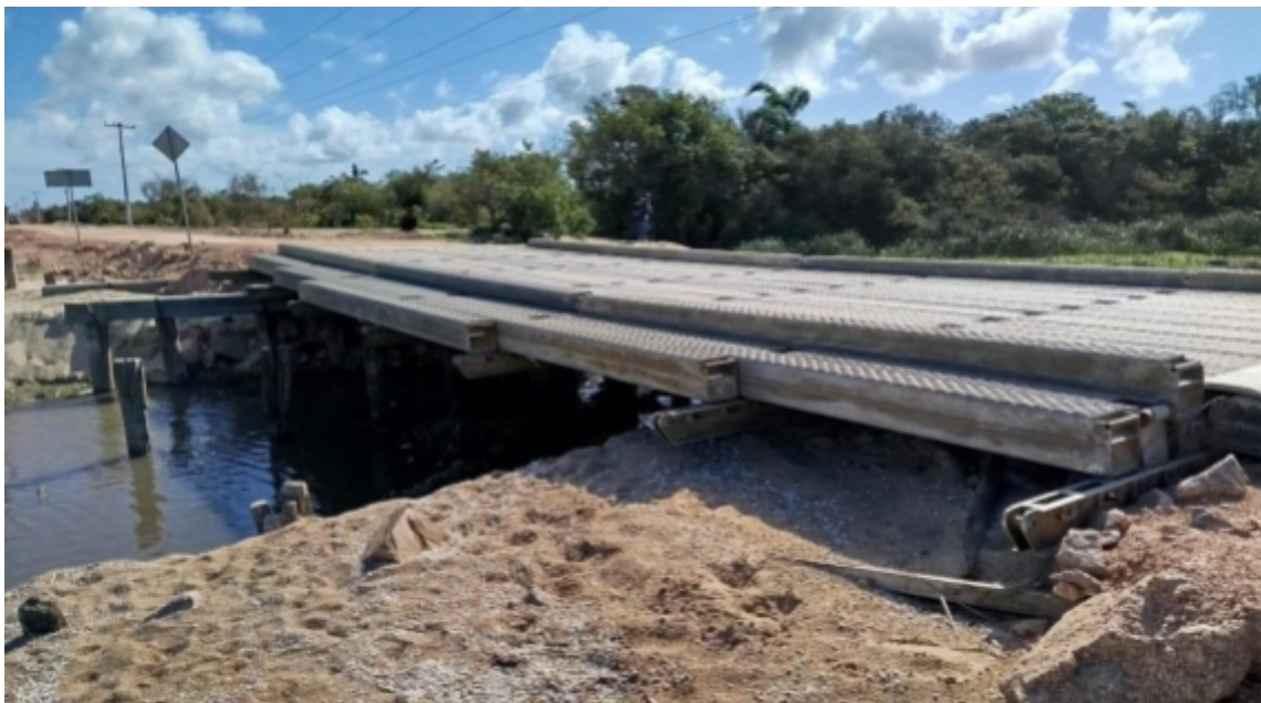
Fig. 3: Imagem da ponte provisório do Exército Brasileiro, montada sobre destroços da antiga ponte da Colônia Z-3 (imagem de set/24)
